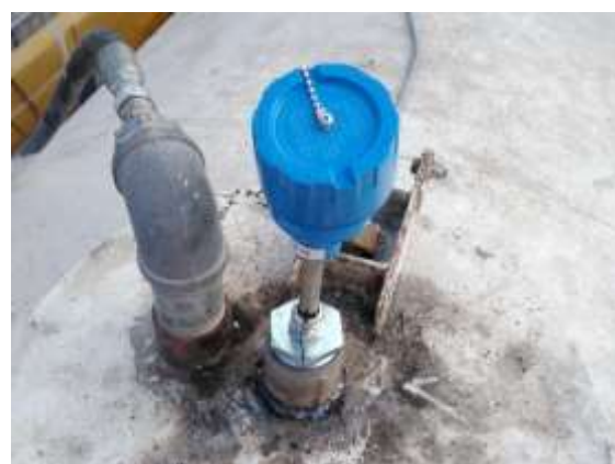
Instalación Level Shield, (en tapa modificada)
