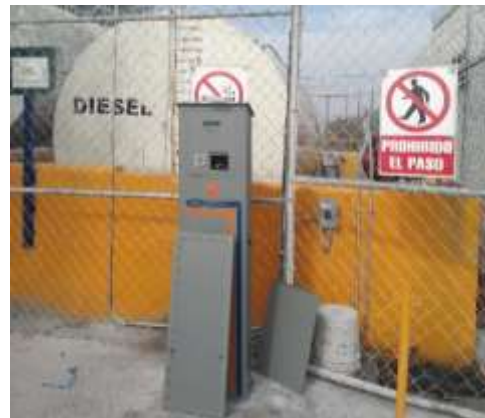
Instalación de Fuel Shield
