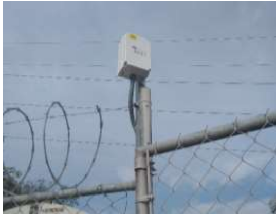
Instalación de antena
