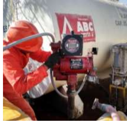
Instalacion Medidor electronico
